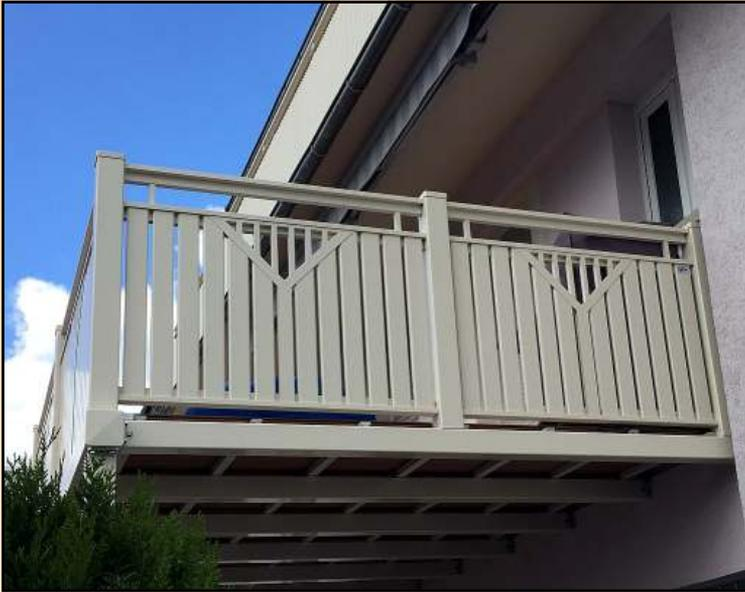
Anbaubalkon mit Alu-Lattengeländer vertikal mit Teiler „Y“ Stab 22
