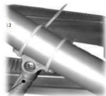
Setzen Sie nun die Handlauf-Rohrsegmente auf die Handlaufhalter von unten beginnend. Ein hervorragendes Hilfsmittel zur vorläufigen Befestigung der Elemente sind Kabelbinder mind. 14 cm Länge. Den Überstand des Rohres nach unten bestimmen sie nach eigenem Ermessen.
